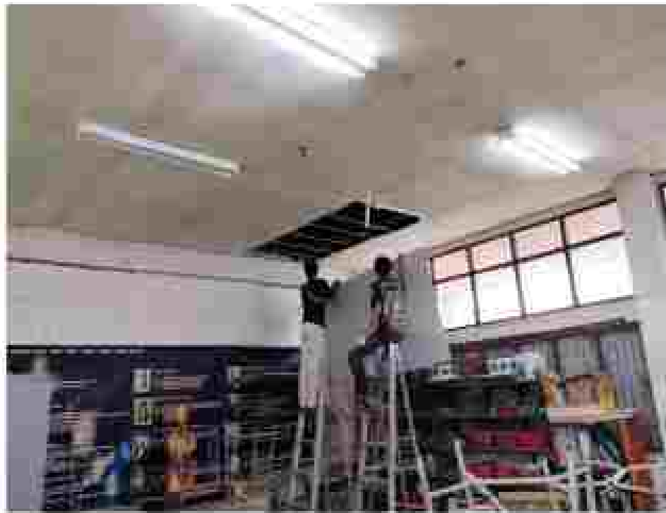
ภาพกิจกรรมการปรับปรุงซ่อมแซมและปรับปรุงภูมิทัศน์
