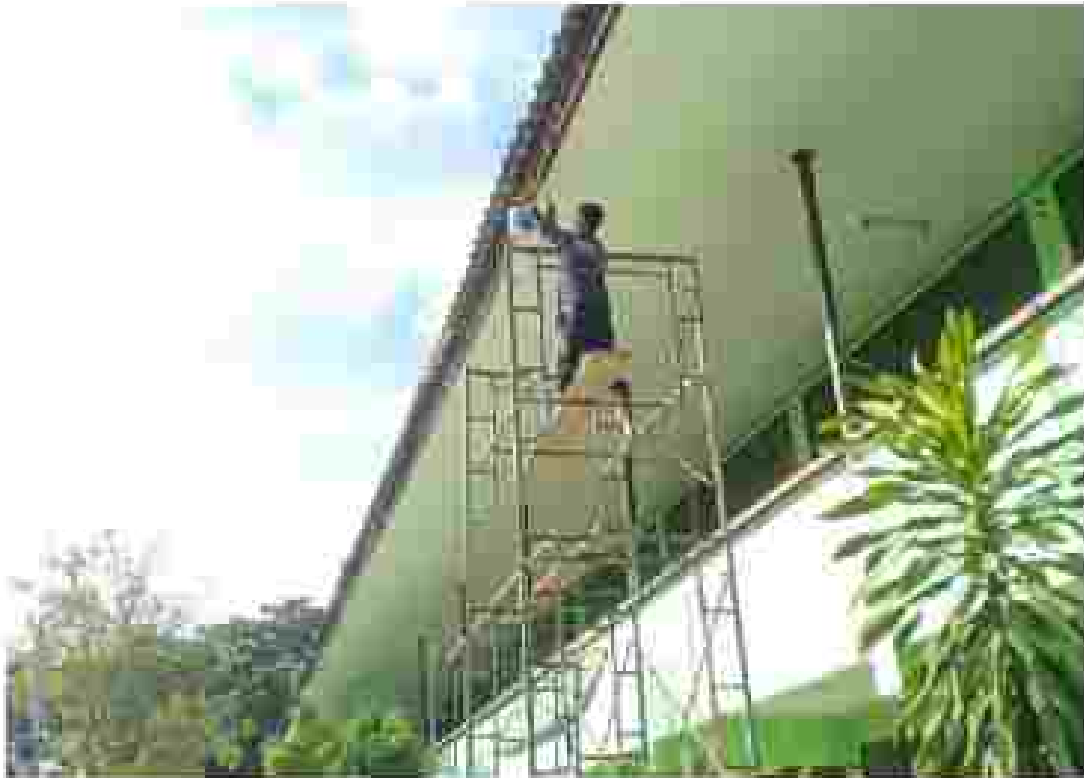
ภาพกิจกรรมการปรับปรุงซ่อมแซมและปรับปรุงภูมิทัศน์
