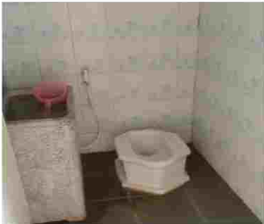
ภาพกิจกรรมการปรับปรุงซ่อมแซมและปรับปรุงภูมิทัศน์
